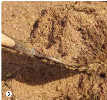
Nach dem Aufbringen und Verteilen des Sand-Splitt-Gemisches sind mit der Grabegabel oder einer Fräse, die beiden Schichten gründlich zu vermischen.
