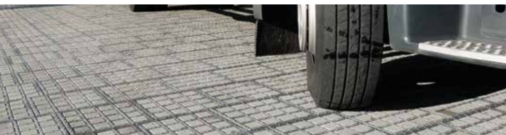
TTE ® Lkw-Fahrstraße auf nur ca. 30 cm mineralischer Tragschicht
