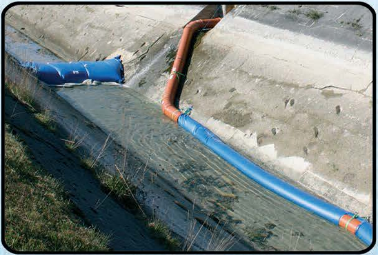
Schlauchrohr und Mobilten Damm in Zusammenarbeit. Einsatzlänge 400m.
