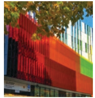
Helsinki Hospital - Finnland Gesundheitszentrum
