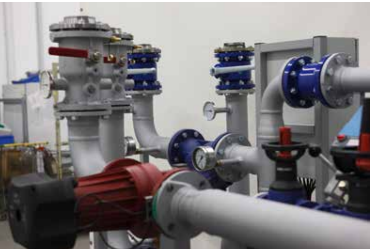
Alle Rohre werden lackiert | All pipes are painted
