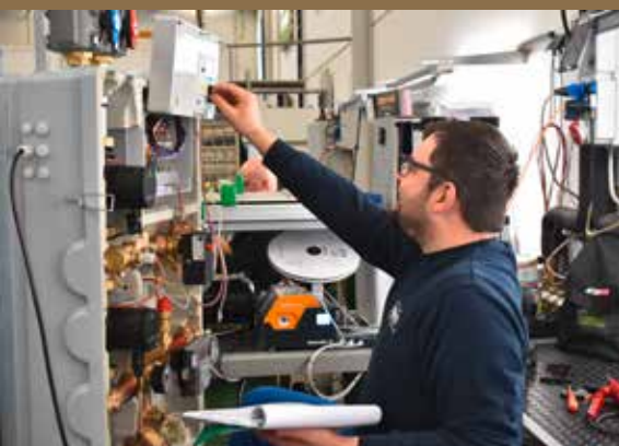
Elektroinstallation im Haus | Inhouse Electric Fitting
