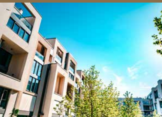
Wohnanlage mit Wohnungstationen | Residential complex with housing stations
