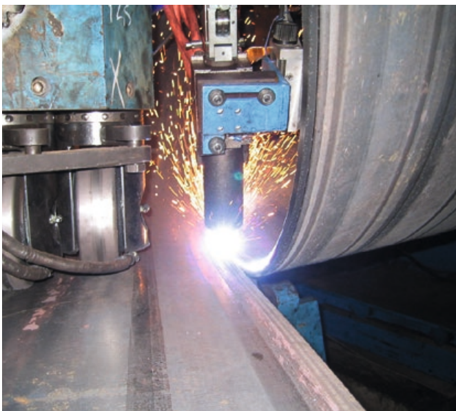
Plasmaschneiden von Stahlplatten
